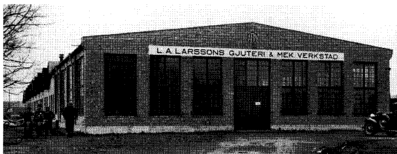
1929 tillkom en stor monteringshall i främre delen av fabriken.
